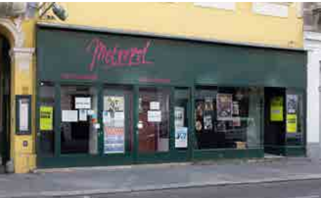
Abb. 13: Fassade Hernalser Hauptstraße 55, Theaterverein Wiener Metropol
