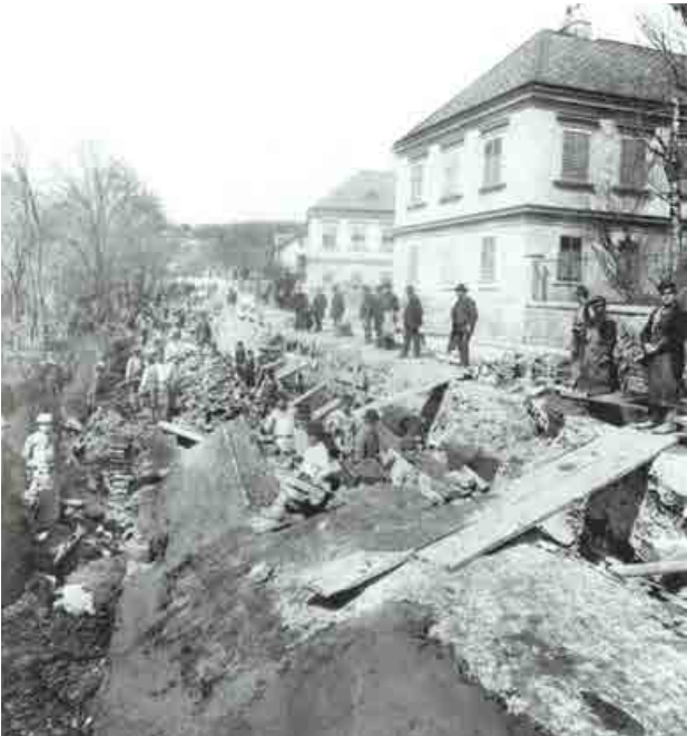
Abb. 23: Einwölbung des Alserbaches 1885
